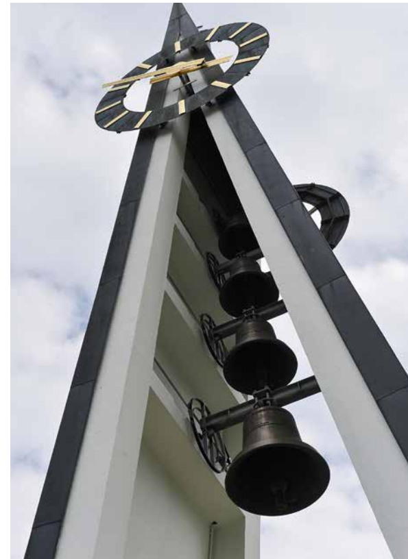
Reformierte Kirche Buochs mit vier Glocken, alle mit Klöppelschutz, damit niemand auf dem Kirchenplatz vom Klöppel erschlagen wird. Robert Fischlin
