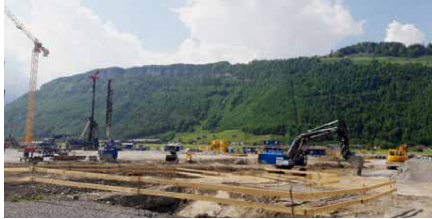
Baustelle zwischen Stans und Buochs.
