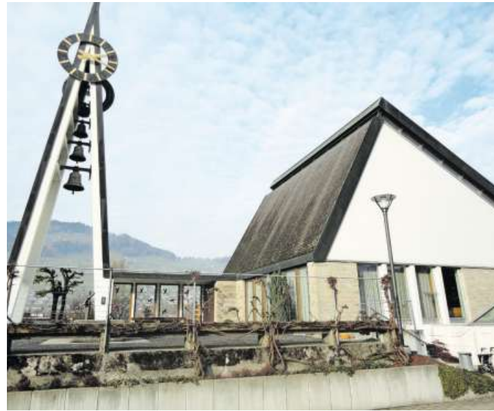
Die reformierte Kirche in Buochs muss saniert werden.
